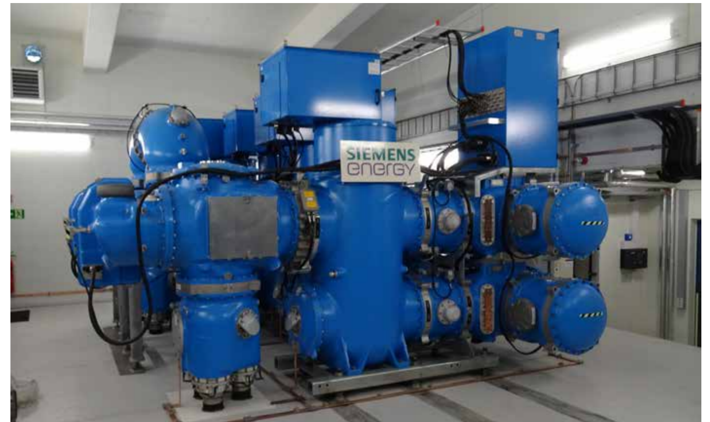
↓ SF 6 -fritt koblingsanlegg Foto: Anita Foshaug
