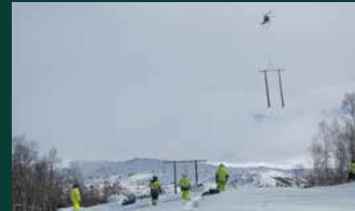
03 Oppstart bygging av ny transformatorstasjon i Saltstraumen inklusive bygging av 132 kV-kraftledning Hopen – Saltstraumen. Styrke forsyningsikkerheten lokalt i Saltstraumen, samt regionalt for Bodø og i sørlige deler av konsesjonsområdet.
