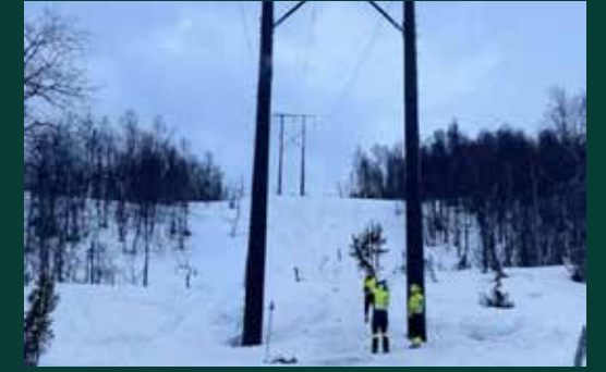
02 Bygging og ferdigstillelse av 132 kV-kraftledning mellom Finnfjordbotn og Silsand. Viktig for å styrke forsynings-sikkerheten og realisere nytt forbruk på Senja.
