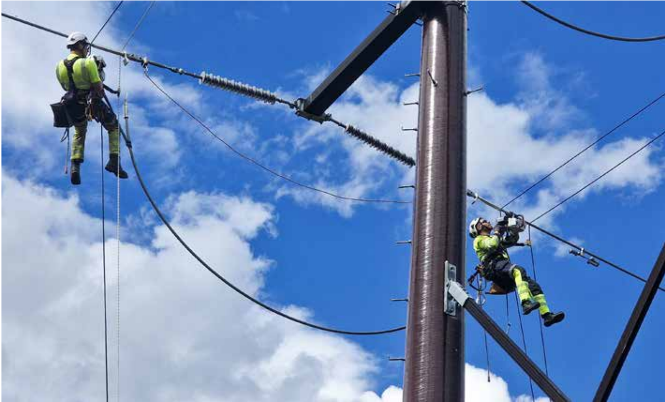
↑ Arva har tatt i bruk et nytt hjelpemiddel: Taumoped som i noen tilfeller kan erstatte de tradisjonelle stolpeskoene. Foto: Arva
